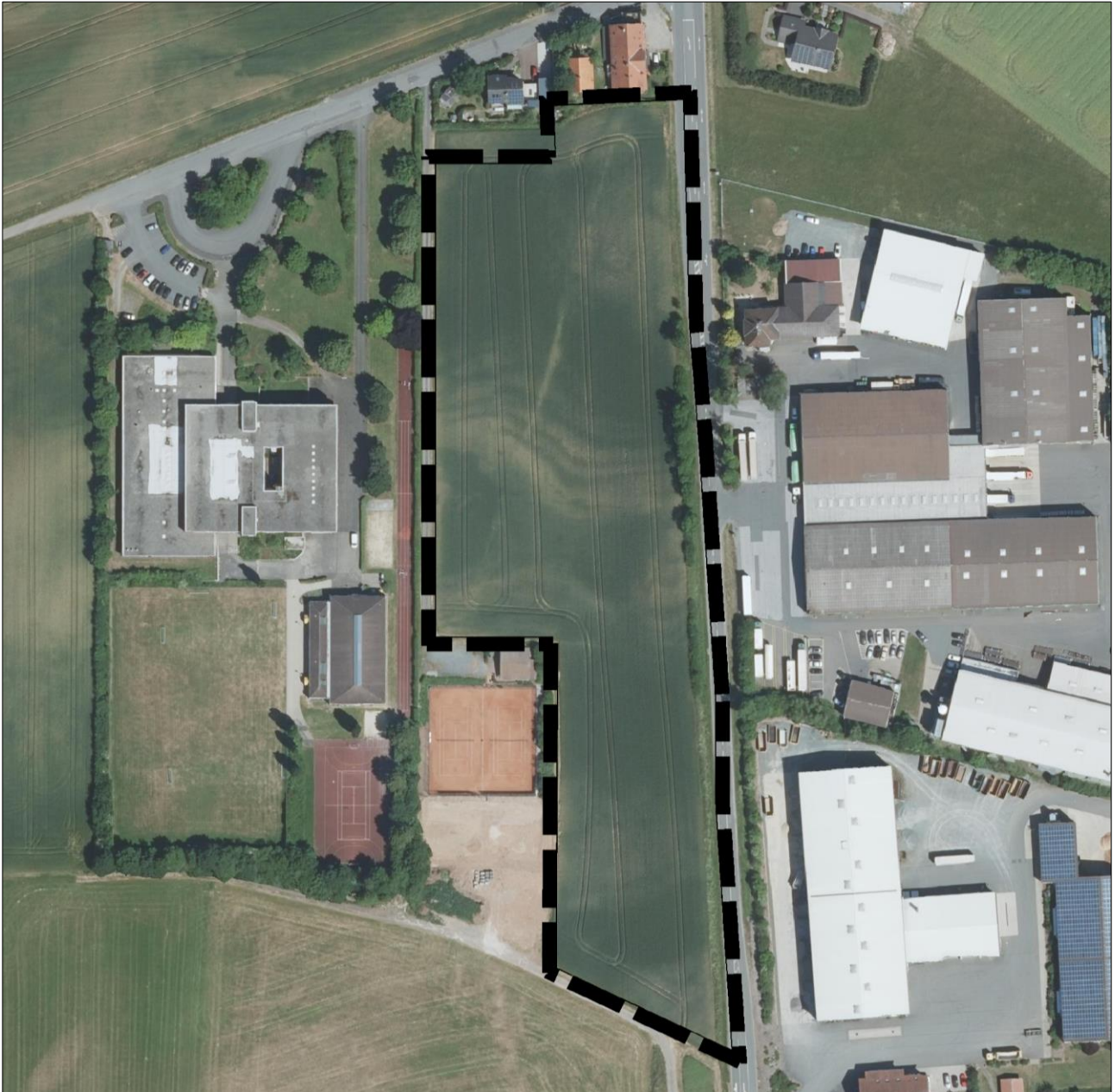
Abbildung 2 - Aktuelle Luftbildaufnahme der für die Bebauung vorgesehenen Flächen
